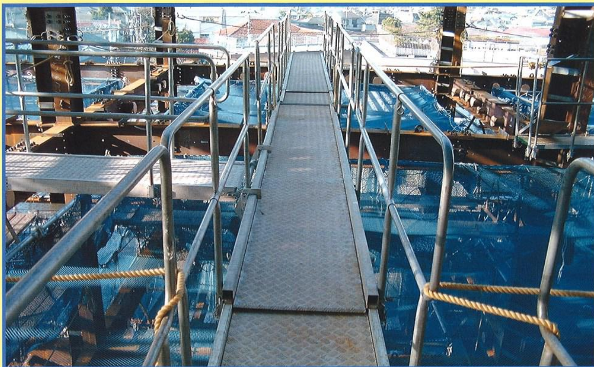
鉄骨上安全通路
