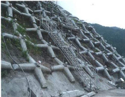
作業員の昇降用通路
