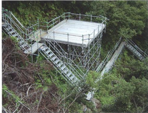
作業員の昇降用通路 (踊場設置例)
