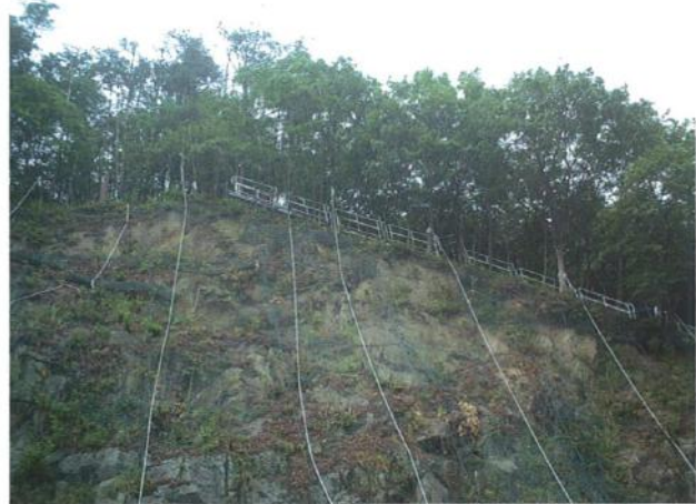
親網点検用としての昇降設備
