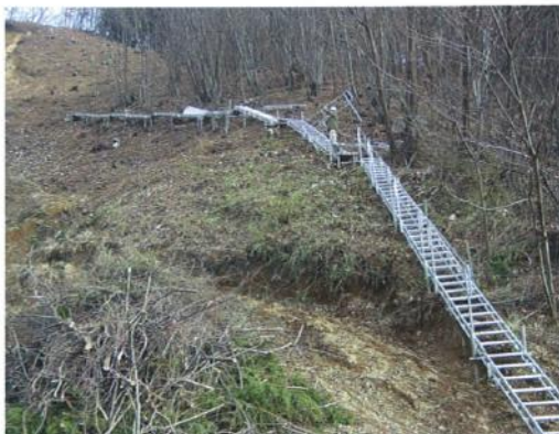
作業員の昇降用通路 (組立状況)
