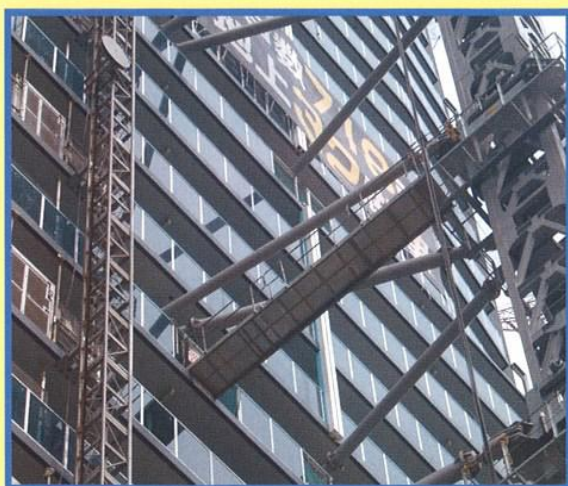
タワークレーン渡り通路
