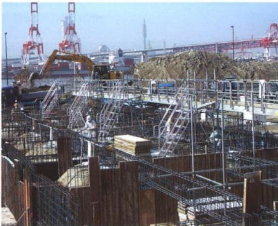
安全通路よりビットへの昇降設備
