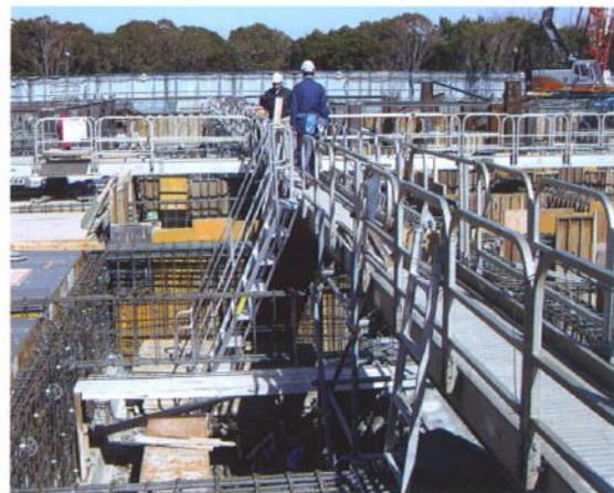
地中梁鉄筋を乗り越える為の使用
