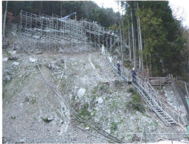
作業員の昇降用通路
