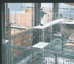
枠組足場で島を作る。
