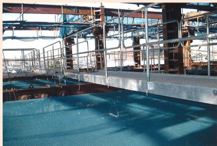
鉄骨上安全通路
