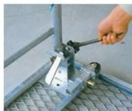
肝心な所はさらにクサビで固定。 扱いはシノひと振りの簡単操作。
