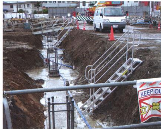
基礎工事の時の昇降設備
