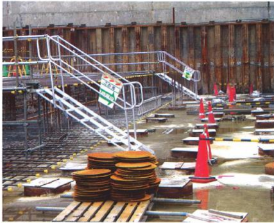
地足場より作業場への昇降設備
