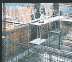
島と島の間にライトブリッジを レッカー(クレーン)で降ろす。
