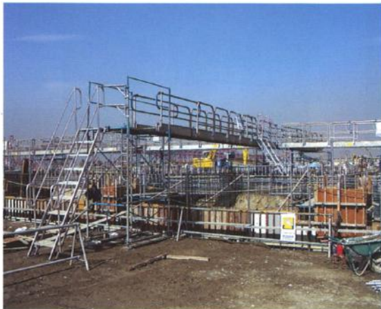
安全通路より作業床面への昇降設備
