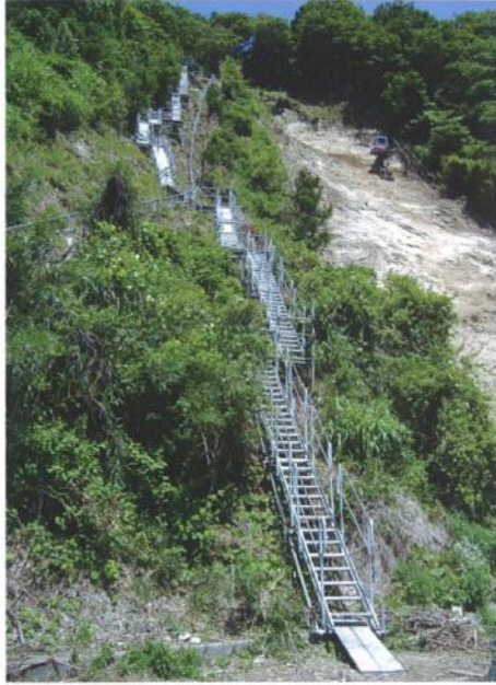
法面工事準備段階で使用
