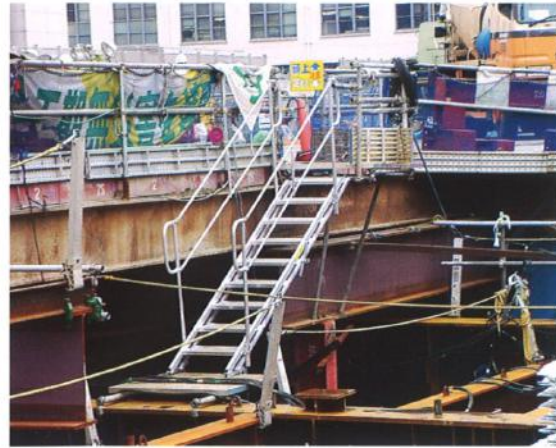
乗入構台より梁上に降りる為の昇降設備
