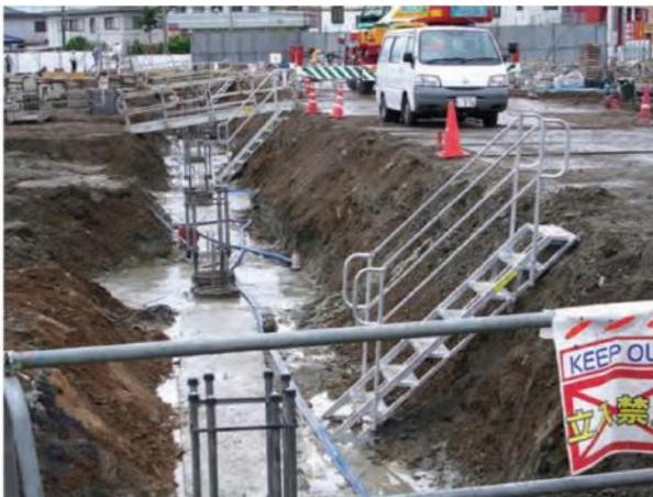
基礎工事の時の昇降設備
