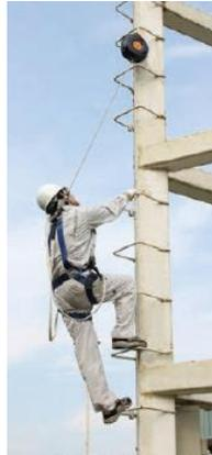
安全ブロックはリトラクタ式墜落阻止器具といい、作業者が高所から落下するのを防止するためのものです。写真のようにフックを安全帯に引掛けて使用します。フックを引張るとキーパー本体からワイヤロープを引き出すことができますが、素早く引出す(使用者が落下する)とブレーキが動作します。また、ワイヤロープの自動巻取り(リトラクタ)機能を備えているため、ワイヤロープは常にピンと張った状態になります。
