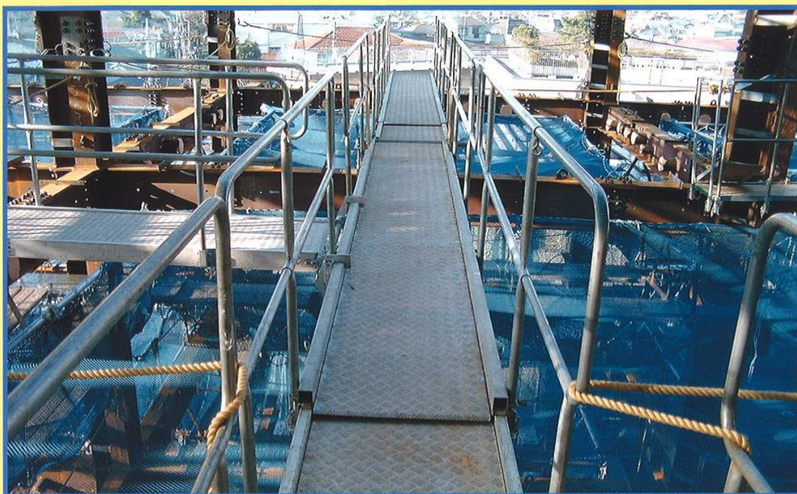
鉄骨上安全通路
