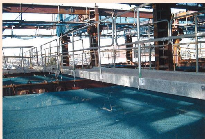
鉄骨上安全通路
