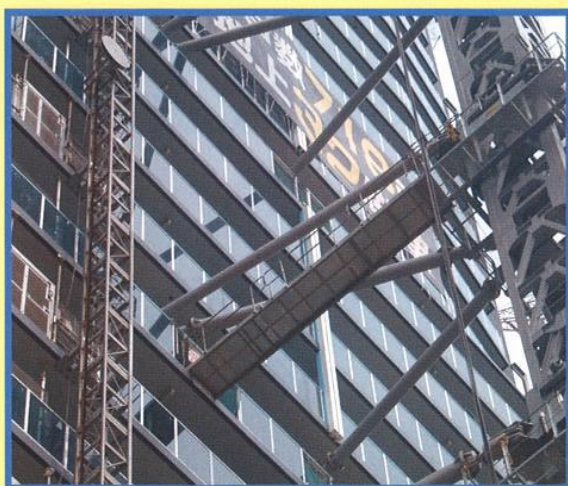
タワークレーン渡り通路
