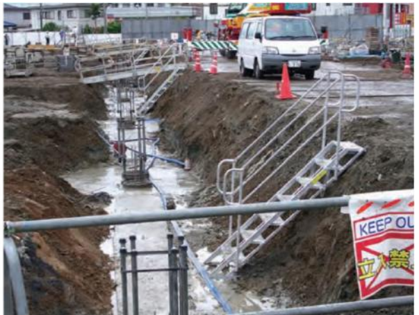
基礎工事の時の昇降設備
