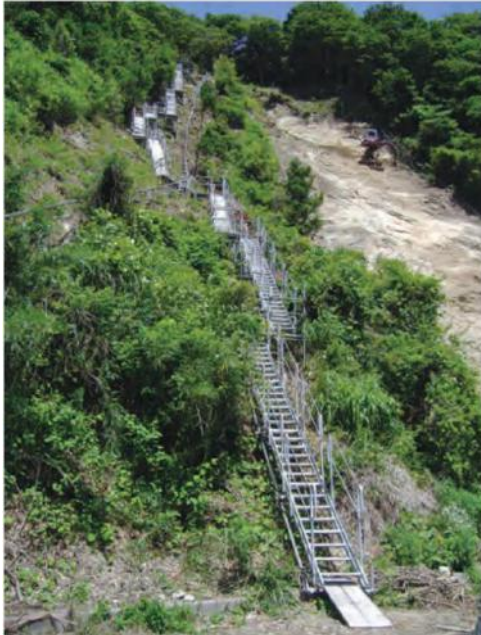
法面工事準備段階で使用
