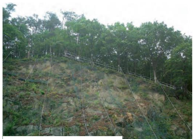
親網点検用としての昇降設備
