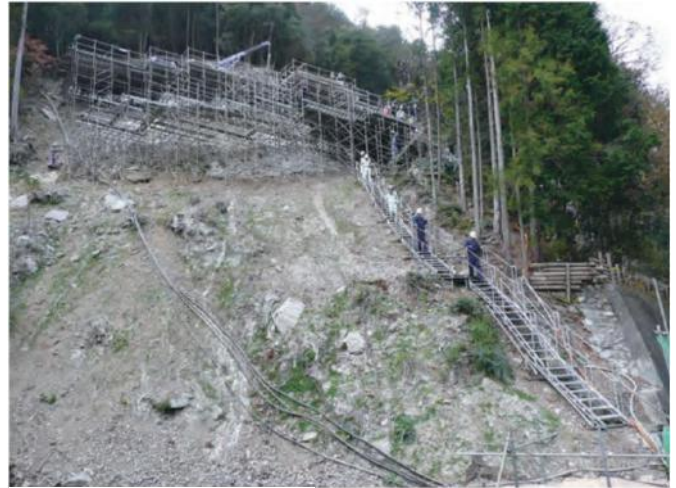
作業員の昇降用通路
