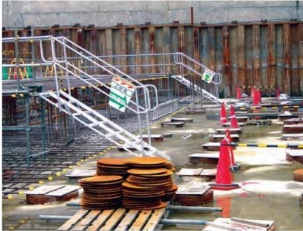
地足場より作業場への昇降設備
