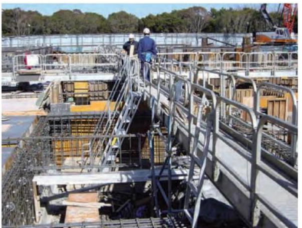
地中梁鉄筋を乗り越える為の使用
