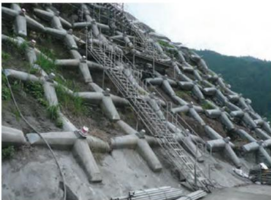
作業員の昇降用通路
