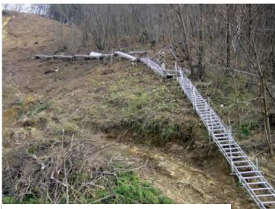
作業員の昇降用通路(組立状況)
