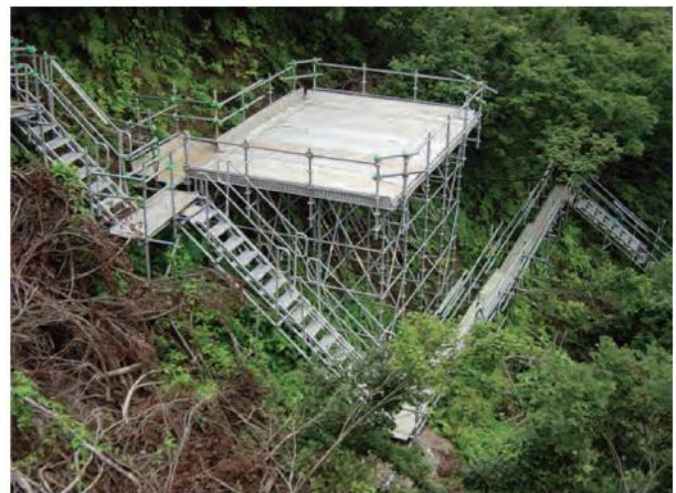
作業員の昇降用通路(踊場設置例)
