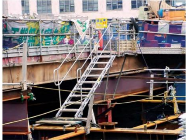
乗入構台より梁上に降りる為の昇降設備
