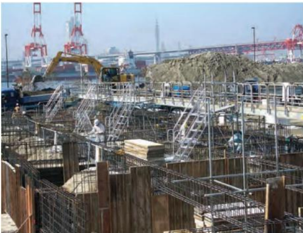
安全通路よりピットへの昇降設備
