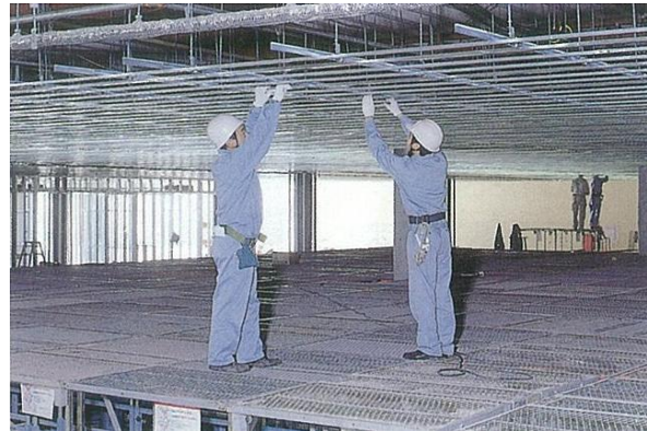
シフトステージを 敷き詰めての作業状況
