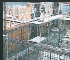
島と島間にライトブリッジを レッカー（クレーン）で降ろす。
