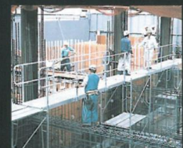
両サイドの枠組足場のパイプに ライトブリッジのフックを掛けて 安全通路が出来上がります。
