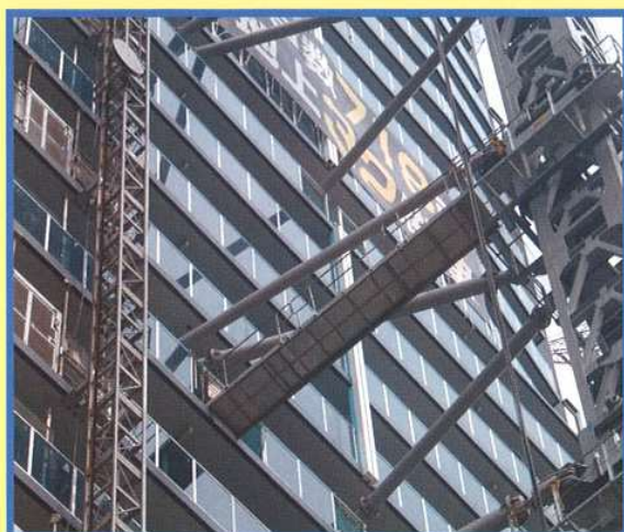
タワークレーン渡り通路
