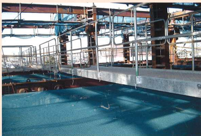
鉄骨上安全通路
