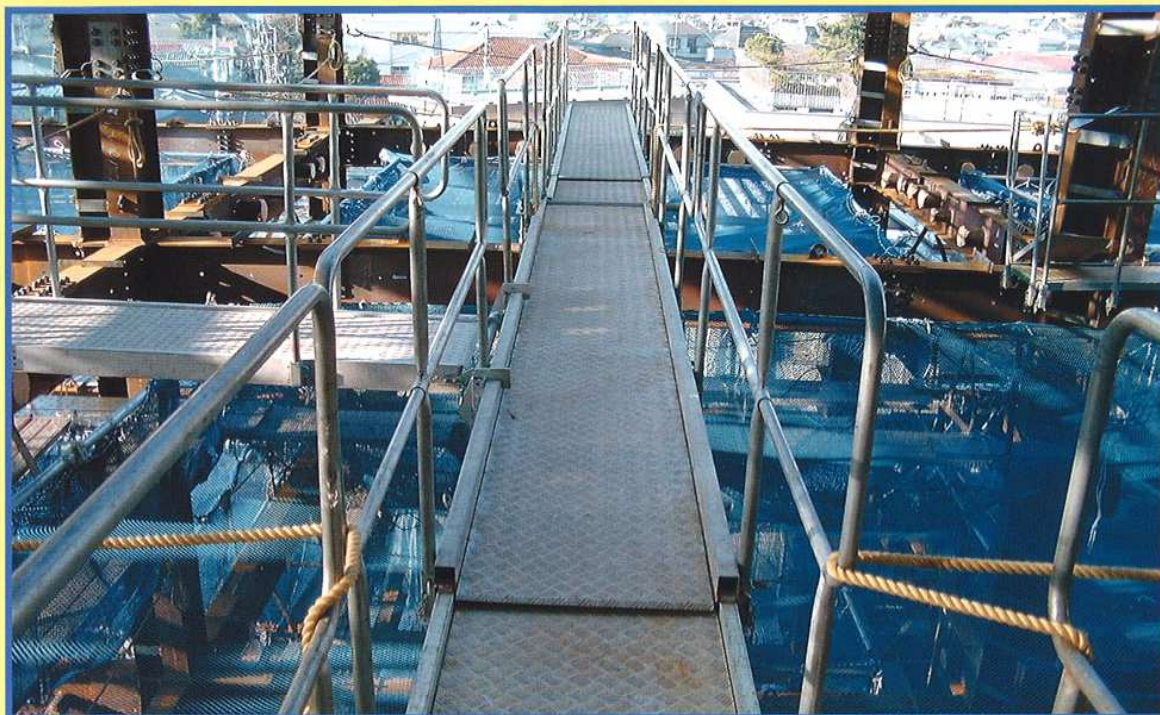
鉄骨上安全通路
