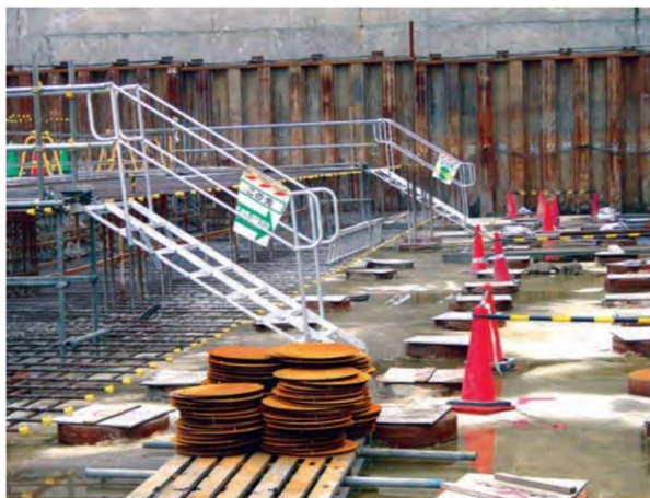
地足場より作業場への昇降設備
