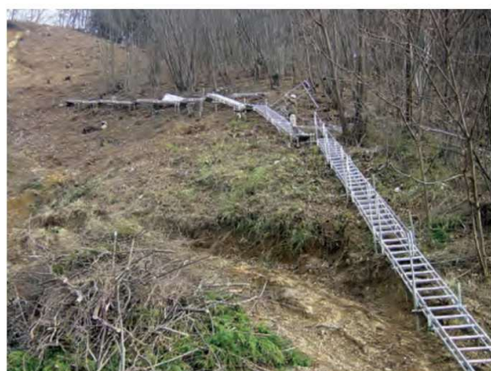
作業員の昇降用通路(組立状況)
