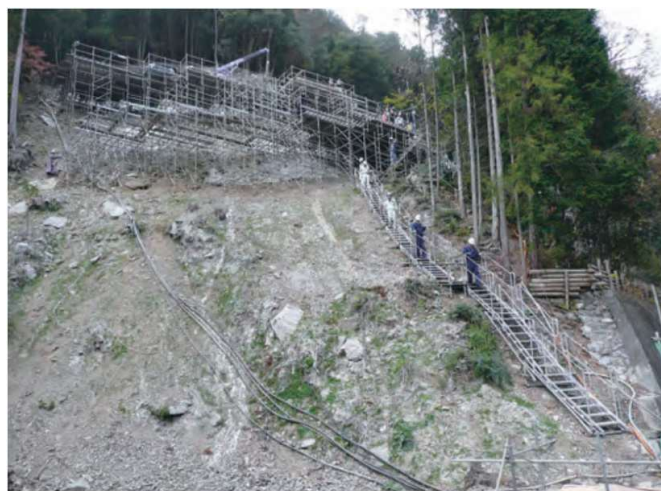
作業員の昇降用通路
