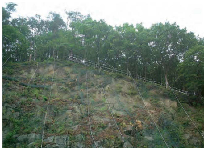
親網点検用としての昇降設備
