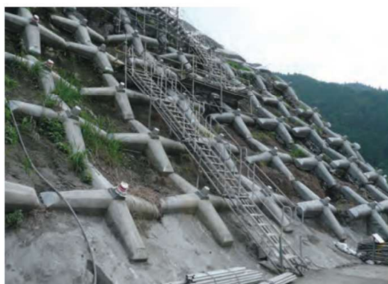
作業員の昇降用通路
