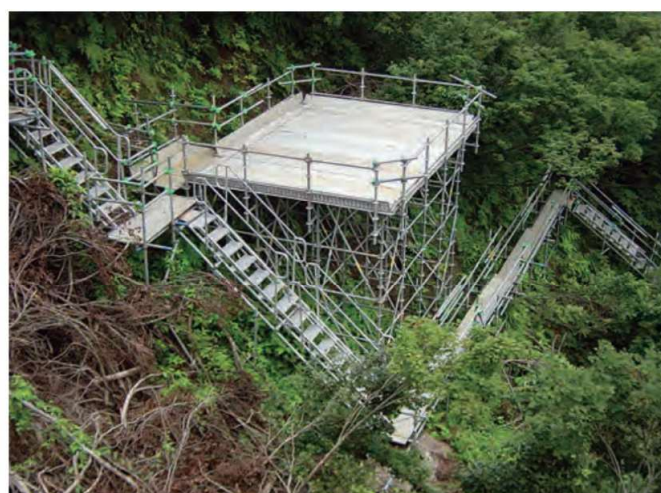
作業員の昇降用通路(踊場設置例)
