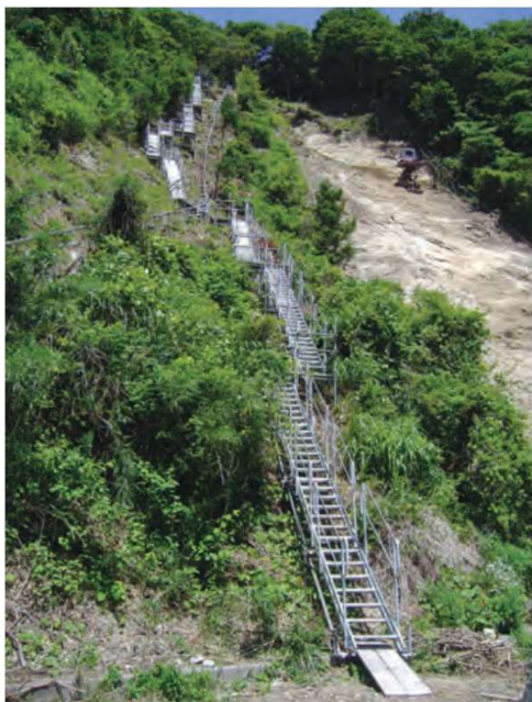
法面工事準備段階で使用
