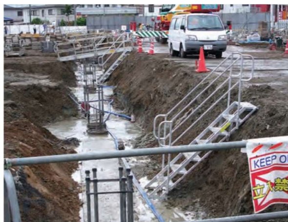
基礎工事の時の昇降設備
