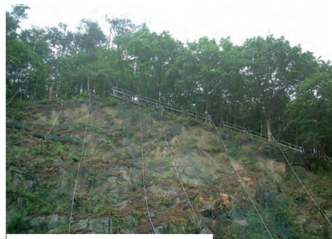
親網点検用としての昇降設備
