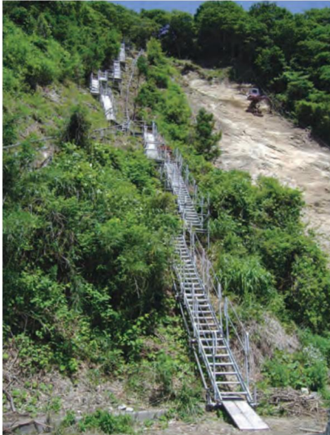
法面工事準備段階で使用
