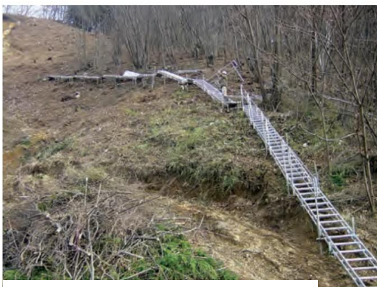
作業員の昇降用通路(組立状況)
