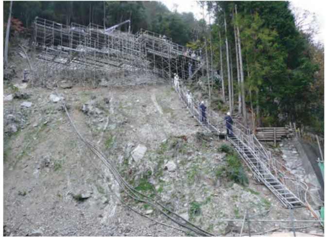
作業員の昇降用通路
