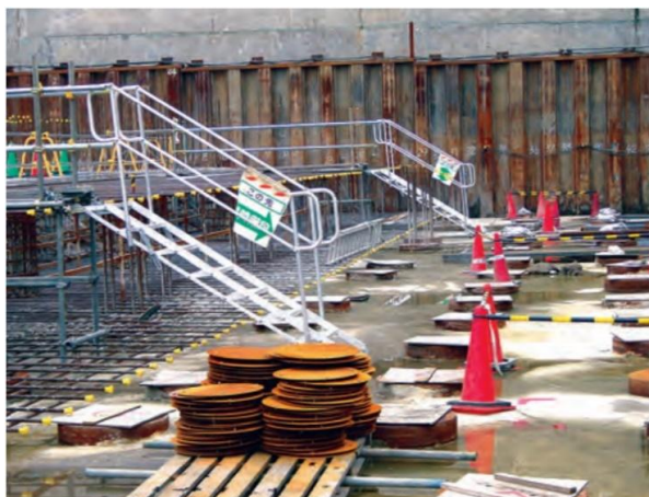
地足場より作業場への昇降設備
