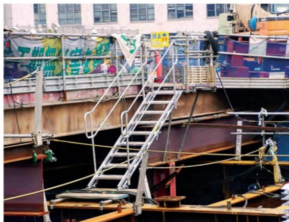
乗入構台より梁上に降りる為の昇降設備
