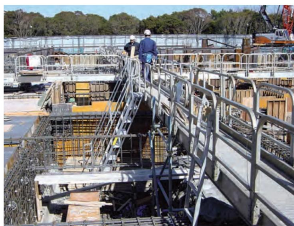
地中梁鉄筋を乗り越える為の使用
