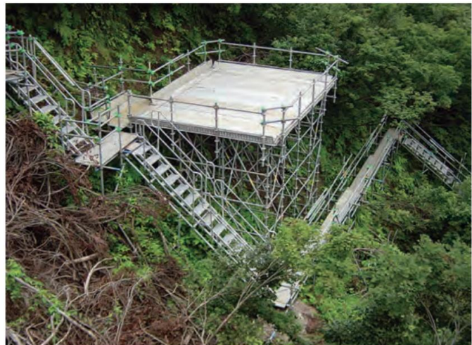
作業員の昇降用通路(踊場設置例)
