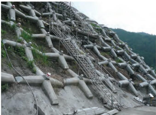
作業員の昇降用通路
