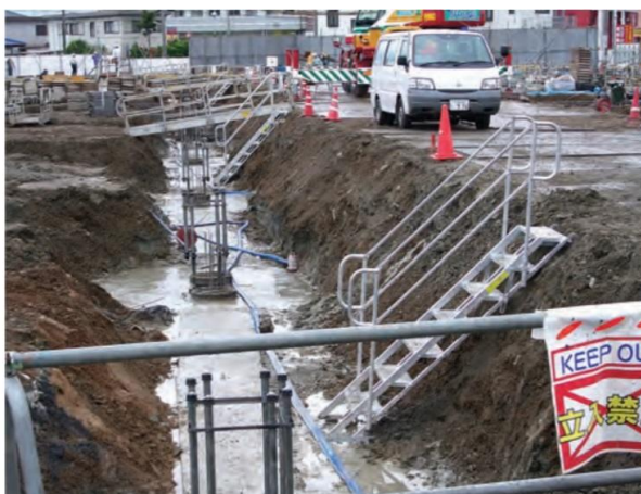
基礎工事の時の昇降設備
