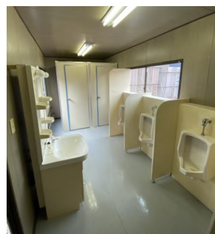
※ユニットハウス内へ設置
