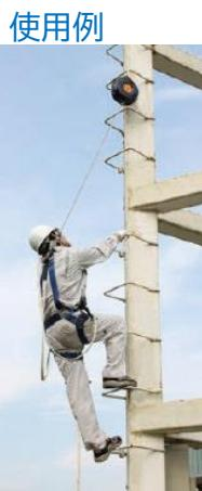
安全ブロックはリトラクタ式墜落阻止器具といい、作業者が高所から落下するのを防止するためのものです。写真のようにフックを安全帯に引掛けて使用します。フックを引張るとキーパー本体からワイヤロープを引き出すことができますが、素早く引出す(使用者が落下する)とブレーキが動作します。また、ワイヤロープの自動巻取り(リトラクタ)機能を備えているため、ワイヤロープは常にピンと張った状態になります。
