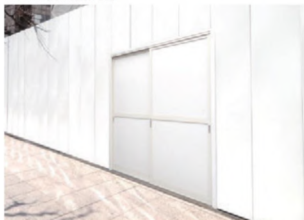
■アドフラット引違い戸設置写真（表側）
