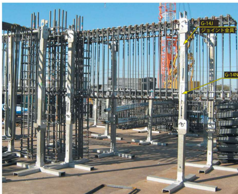
G-14N + G-14J H=1900mm 重量41kg (受け金具2ヶ含む) 許容荷重:300kg
