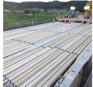
表面は歩廊、裏面は傾斜梯子として使用できる1台2役のアルミ歩廊梯子です。つないで、歩く、登る。現場の機動力向上に貢献します。
