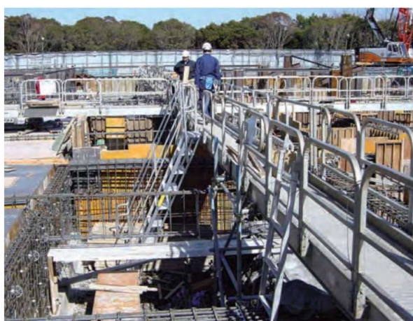
地中梁鉄筋を乗り越える為の使用
