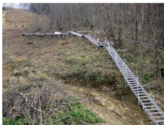
作業員の昇降用通路(組立状況)
