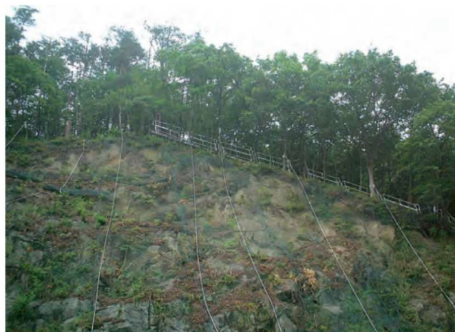
親網点検用としての昇降設備
